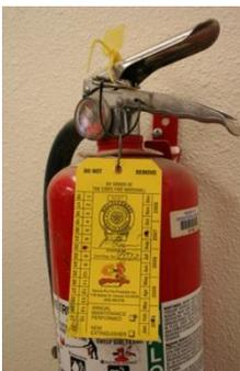
Si l'extincteur est conforme à cette inspection visuelle, la carte d'inspection est poinçonnée sur l'extincteur avec la date et la signature du technicien.
