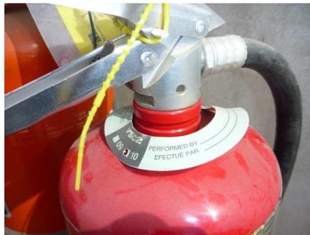
Un collet de vérification ainsi qu'une carte d'inspection (autocollant) doivent être apposés ou poinçonnés sur chaque extincteur après cette opération.
