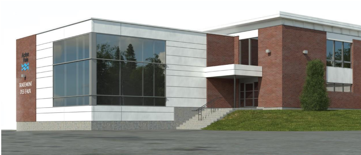
Usine de filtration – ville d'Acton Vale
