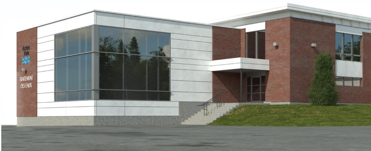
Usine de filtration – ville d'Acton Vale
